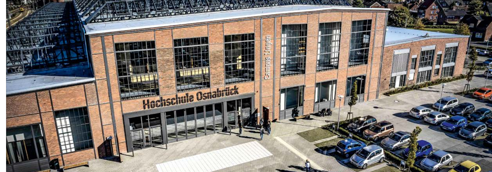
Am Standort Lingen wird die Campus-Halle seit 2012 dank 40 Erdbohrungen mit einer Tiefe von je 90 Metern mit regenerativer Erdwärme versorgt. Die Bohrungen befinden sich unterhalb des Parkplatzes vor der Halle.
