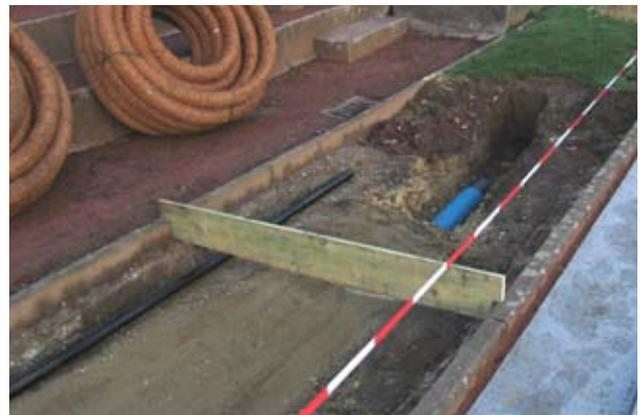
Abb. 2: Bau Finnbahn RWTH Aachen (Entwässerung und Versickerung)
