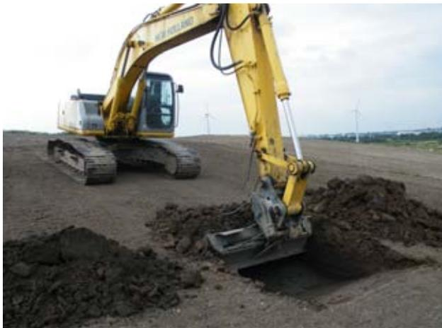
Abb. 1: Aufgrabung eines Bodenprofils auf der Deponie
