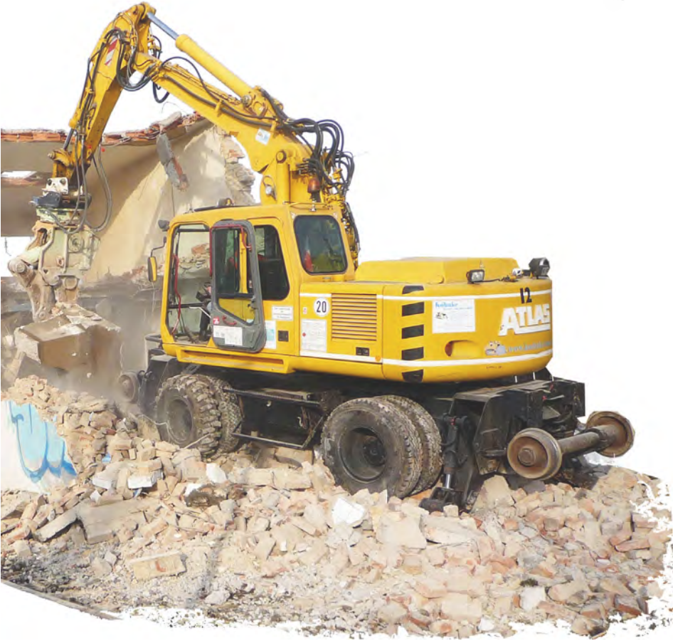
Bildsequenz Abrissmaßnahmen mit einem Bagger
