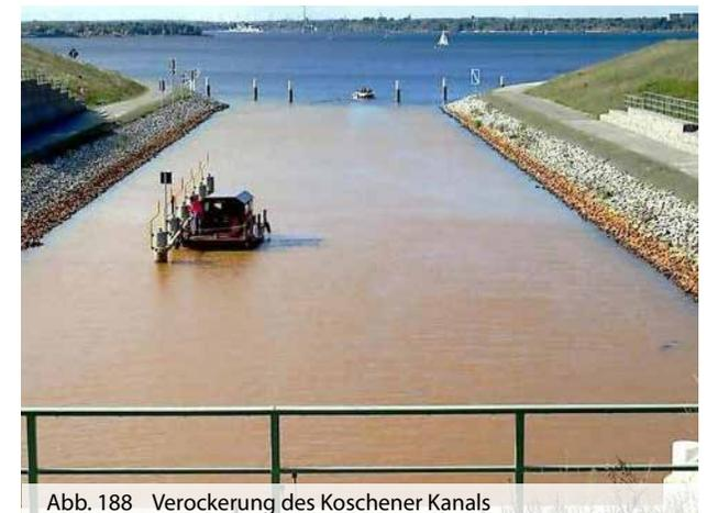
Abb. 188 Verockerung des Koschener Kanals
