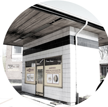
Ehemaliges Tankstellenhäuschen Kreuzung Hauptst./ Berger Str./ Bahnhofsstr. Erbaut um 1960
