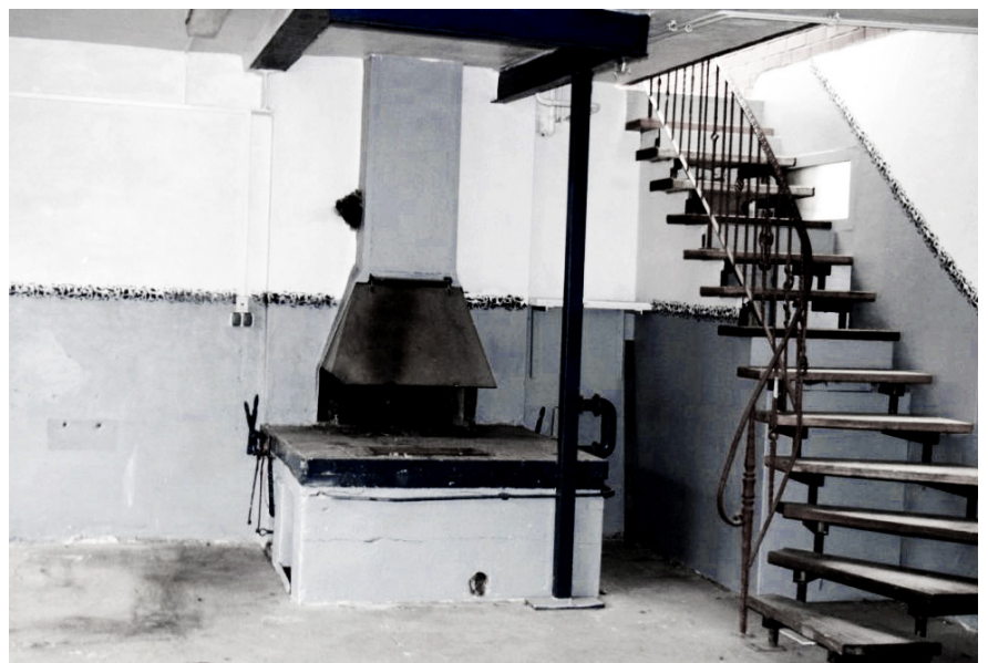
Abb. 58 Feuerstelle mit Abzug
