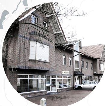
Am Schützenplatz 2 Erbaut um 2000
