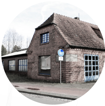
Alte Schmiede Hauptstraße 1 Erbaut um 1930
