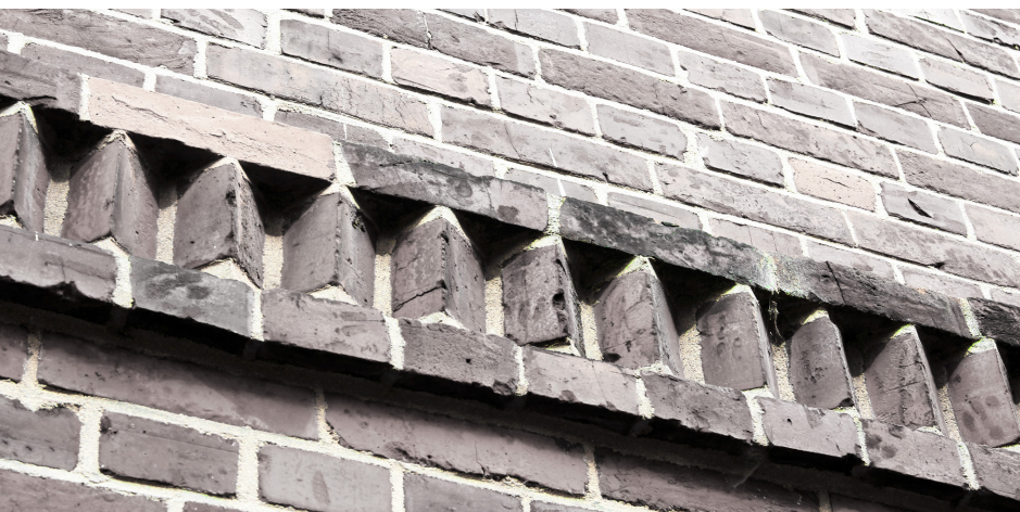
Abb. 25 Fassadenrelief der Klinker-Architektur
