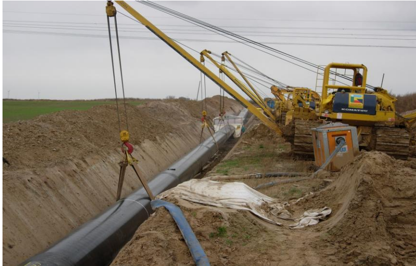
Abb. 10: Rohrstrang und Rohrverleger
