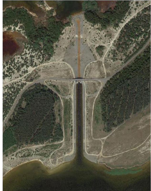
Abb. 35 Rosendorfer Kanal mit Sperrwerk (Foto: LGB [Hrsg.] o. J.)
