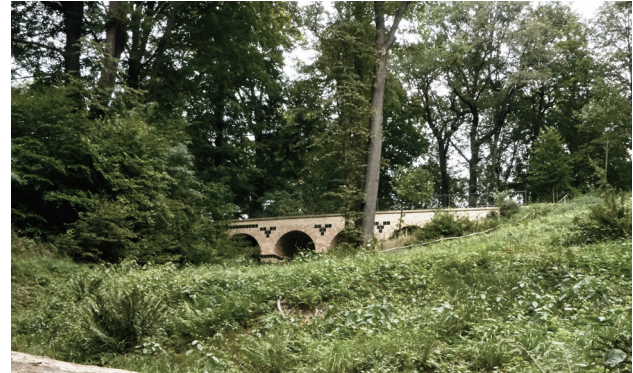
Abb. 66 Viadukt im polnischen Teil der Parkanlage (Foto: SIEFKER 2017)
