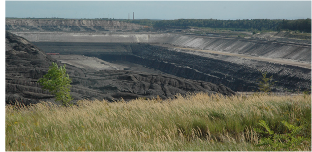
Abb. 12 Abbruchkanten am Tagebau Cottbus Nord (Foto: BELTING)
