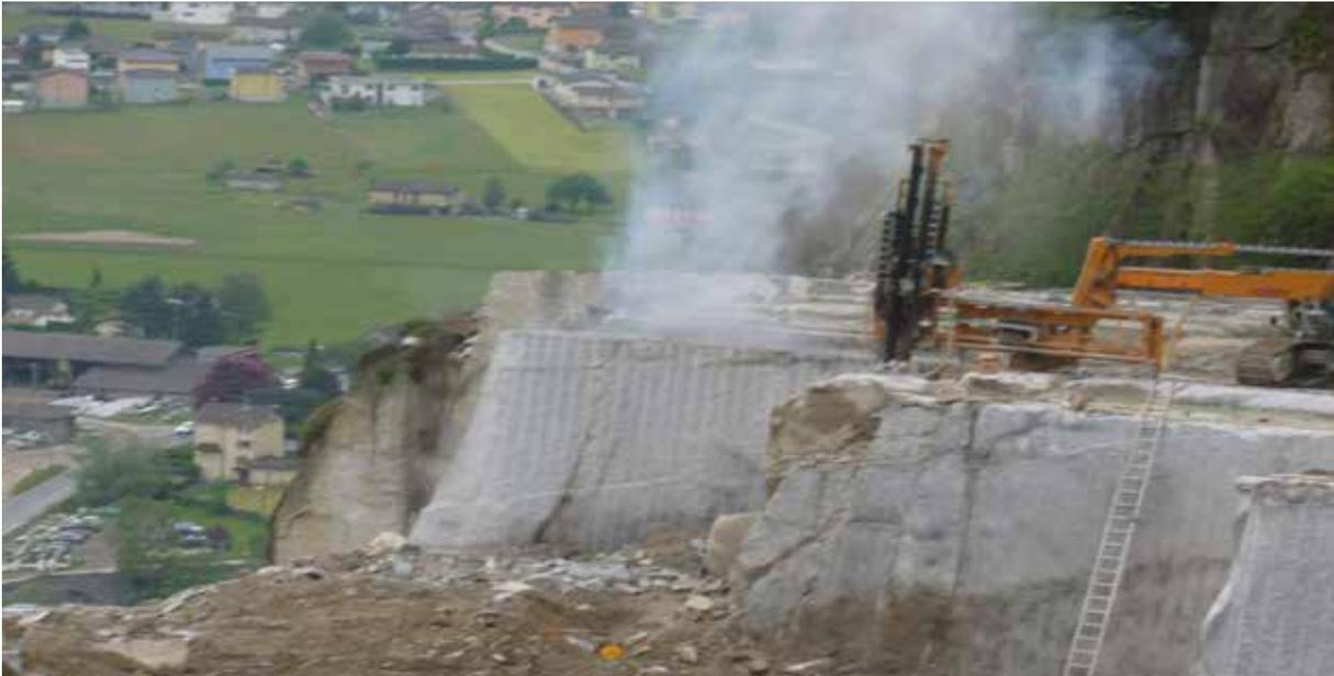
Abb. 11: Sprengung im Steinbruch
