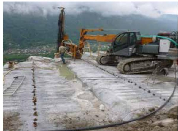
Abb. 7: Bohrgerät; im Vordergrund Bohrlöcher mit Sprengladungen für den Abbau von Gestein in guter Qualität
