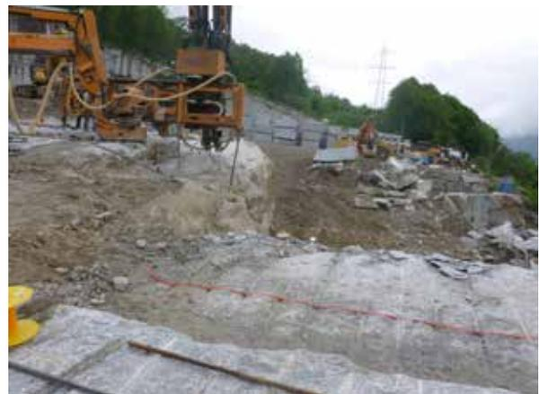
Abb. 8: Bohrgerät; im Vordergrund Bohrlöcher mit Sprengladungen für den Abbau von Gestein in mittlerer Qualität
