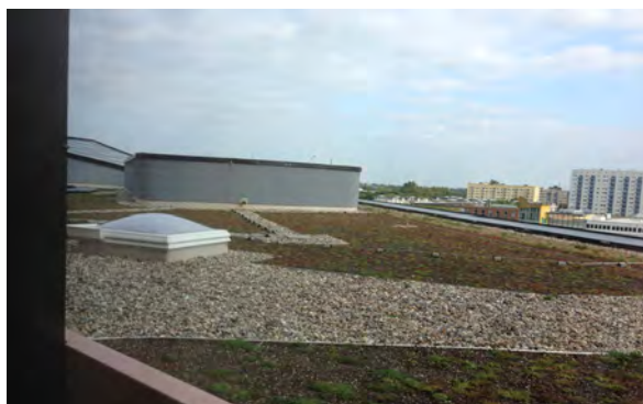
Abb. 3 Extensive Dachbegrünung auf dem BSU - Gebäude
