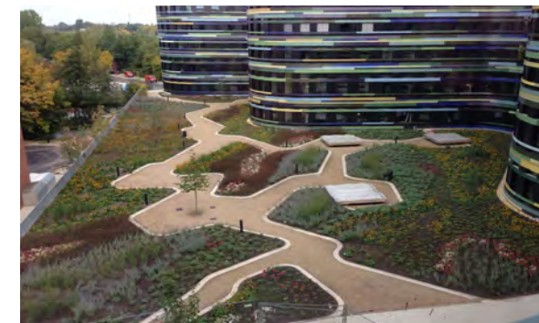
Abb. 5 Intensivbegrünung des Tiefgaragendachs
