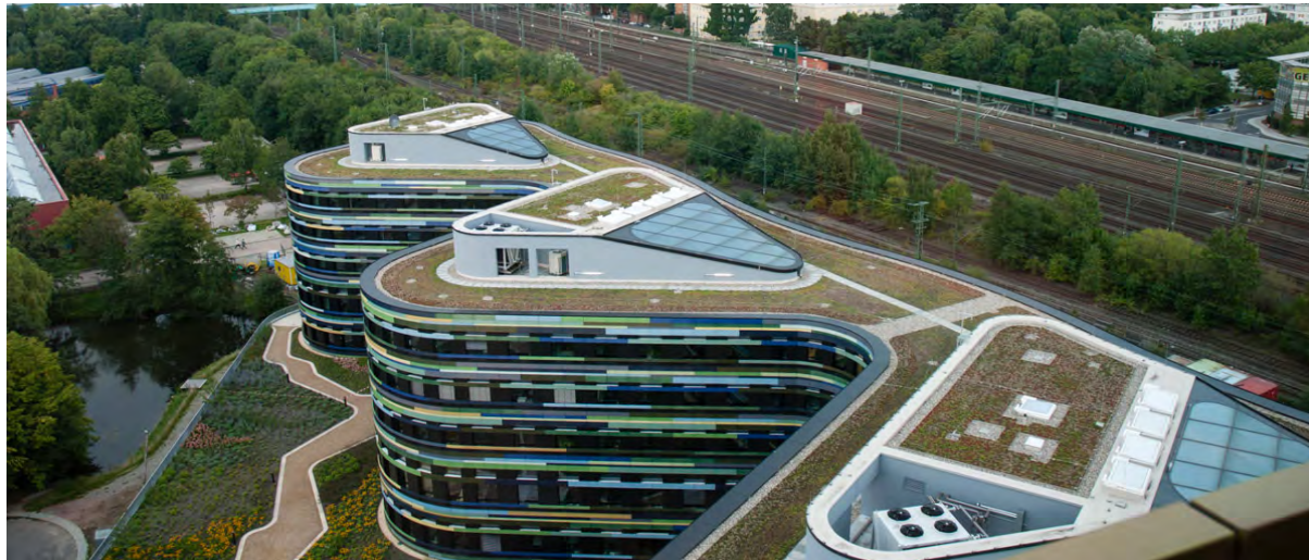
Abb. 2 Blick auf das BSU - Gebäude. Zu sehen ist die Begrünung des Daches sowie des Innenhofes
