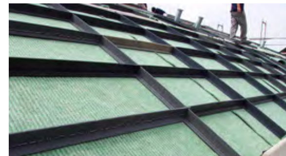
Abb. 12 Schubsicherung eines Schrägdaches
