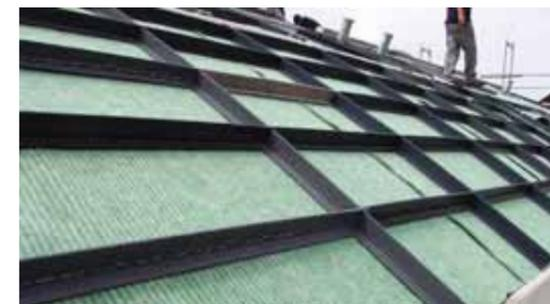
Abb. 12 Schubsicherung eines Schrägdaches
