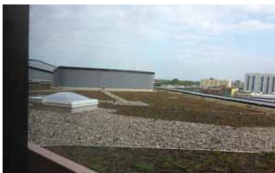
Abb. 3 Extensive Dachbegrünung auf dem BSU - Gebäude
