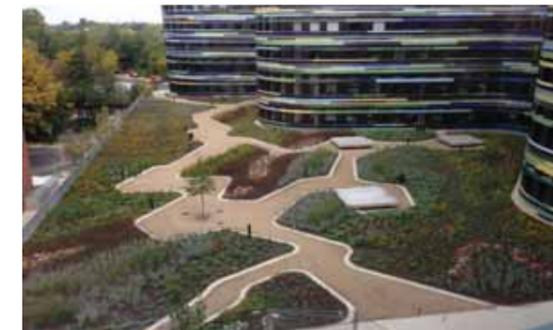
Abb. 5 Intensivbegrünung des Tiefgaragendachs
