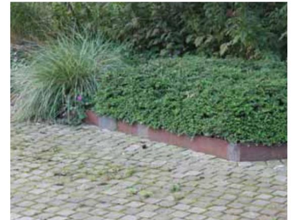
**Abb. 1: Beetfläche mit Cortenstahlkante**
