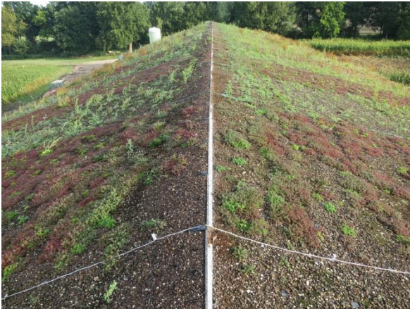
Übersicht Stallgebäude, wechselseitig begrünt mit konventionellem Sedum -Mix und einer Wildpflanzensaatmischung
