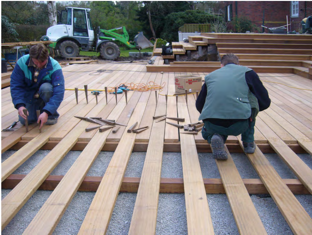
Verlegung der Holzdielen auf der Baustelle
