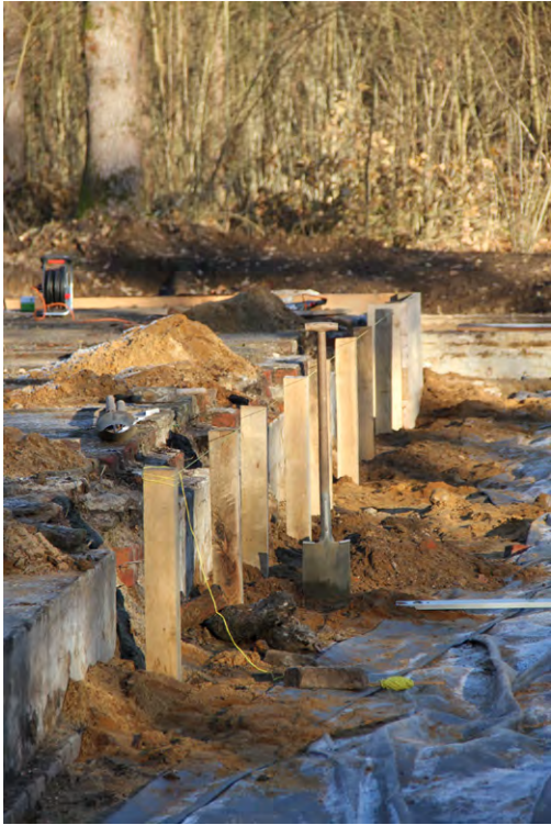
Holzverbau zur Sicherung historischer Relikte
