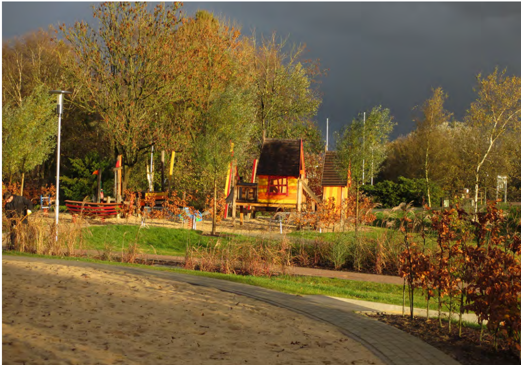
Holzgeräte nach Fertigstellung
