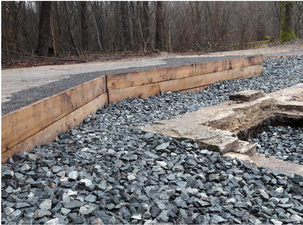
Einfassung des umlaufenden Weges mittels Holzbohlen
