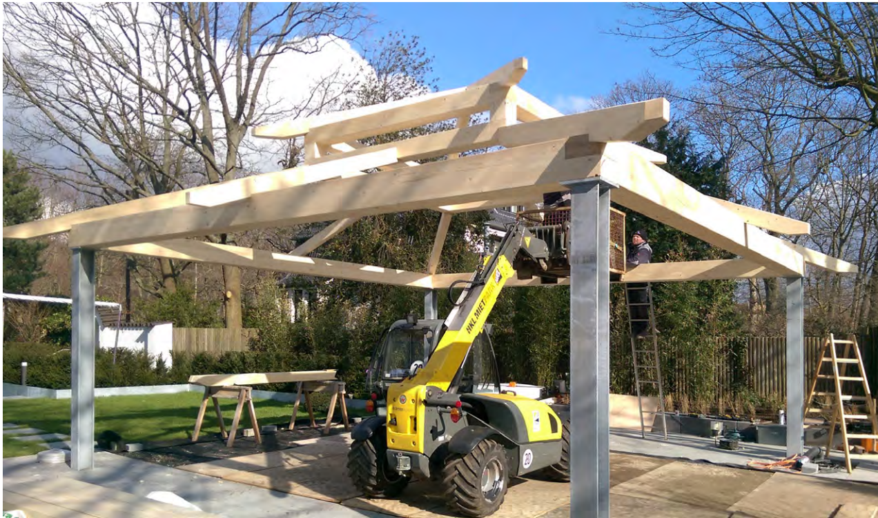
Dachstuhl in der Bauphase
