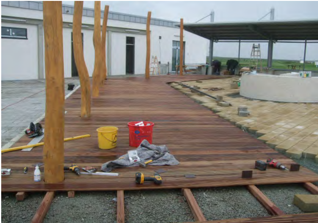
Holzliegedeck in der Bauphase
