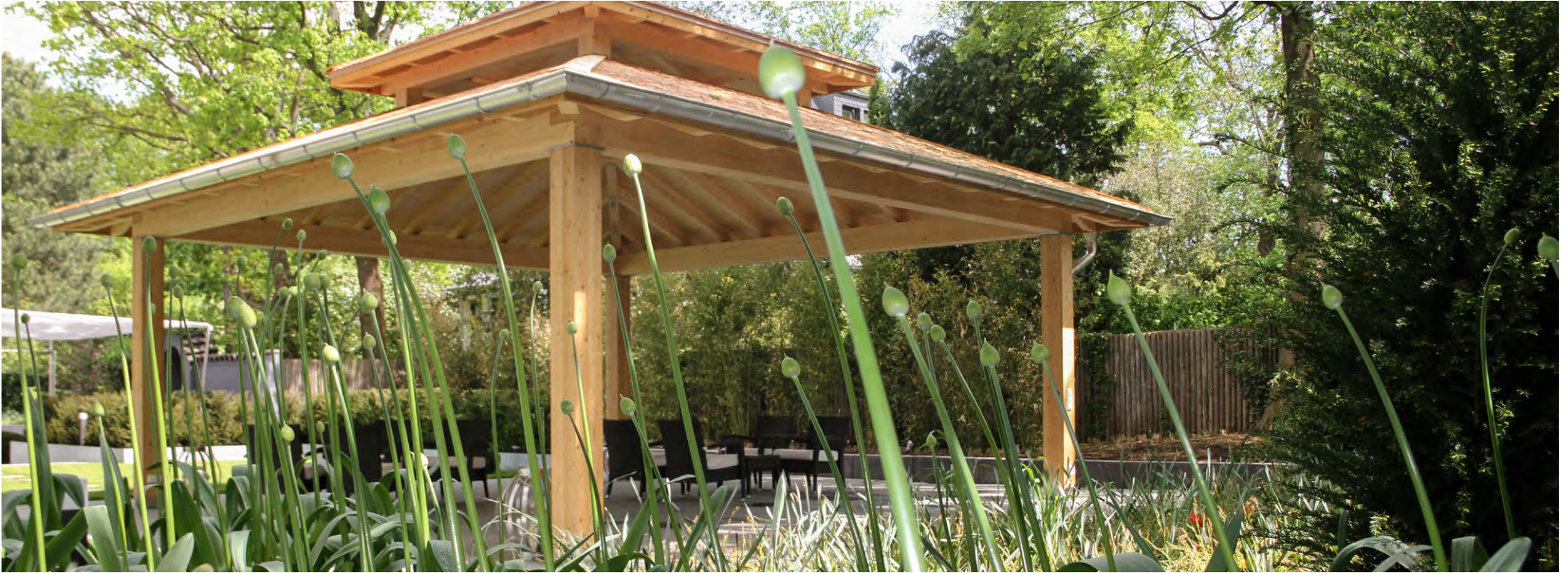
Pavillon zur Überdachung der Außenbestuhlung und Durchführung von Veranstaltungen
