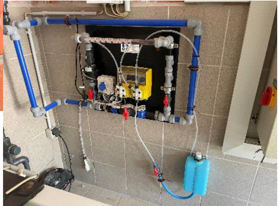
Trinkwasser-Dauerdesinfektion (Chlor/Säure)
