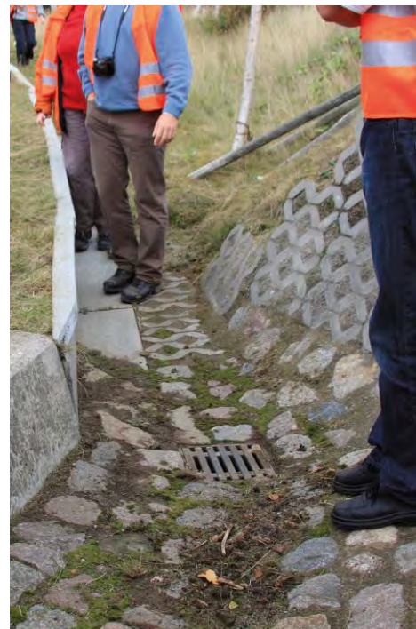
Abb. 36: Amphibienleitzäune auf Querungshilfen führen zu oft unmittelbar auf Gullys und andere Fallen hin. Foto: H. Reck
